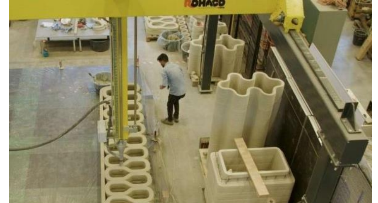
Minder beton in de bouw 3D geprinte fietsbrug in Gemert door BAM
